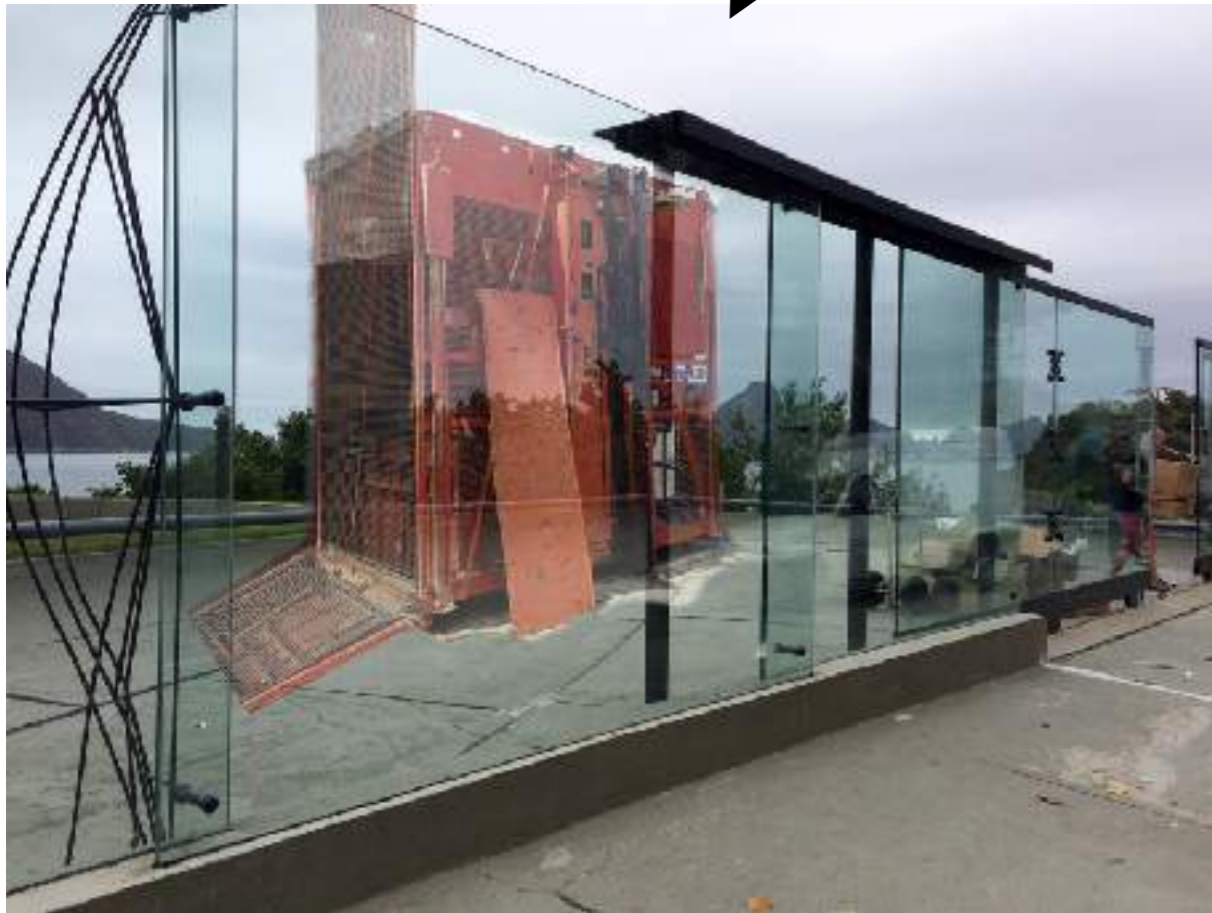
posição final da cabine
