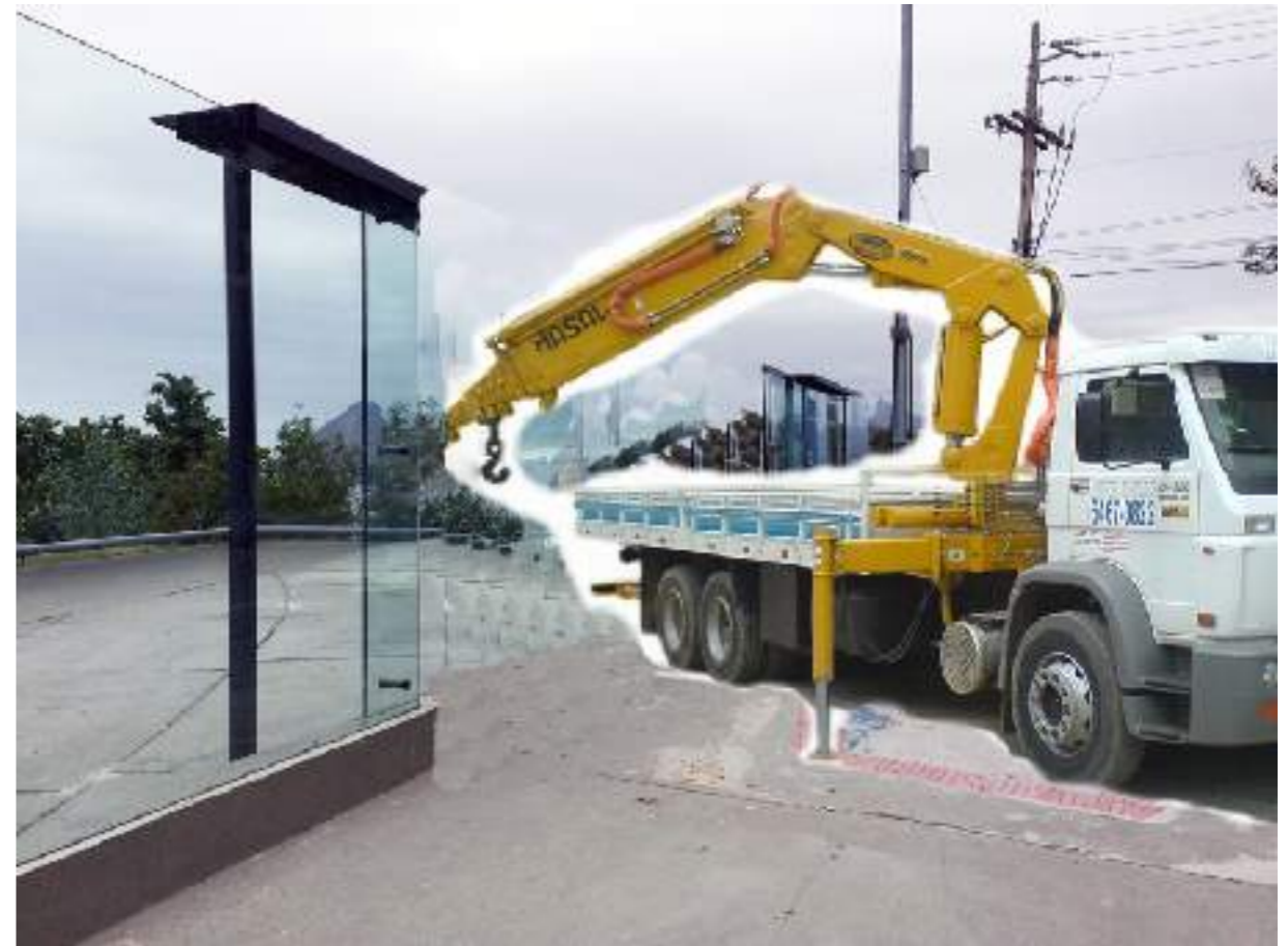
caminhão posicionado no recuo (guia rebaixada) baia: trapézio 6m x 9m
