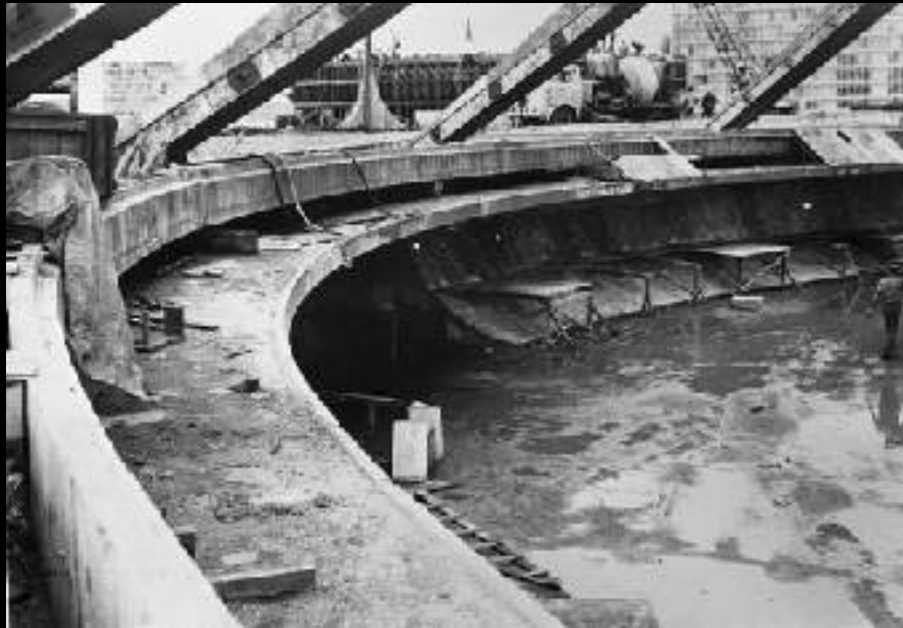
Construção da catedral de Brasília
